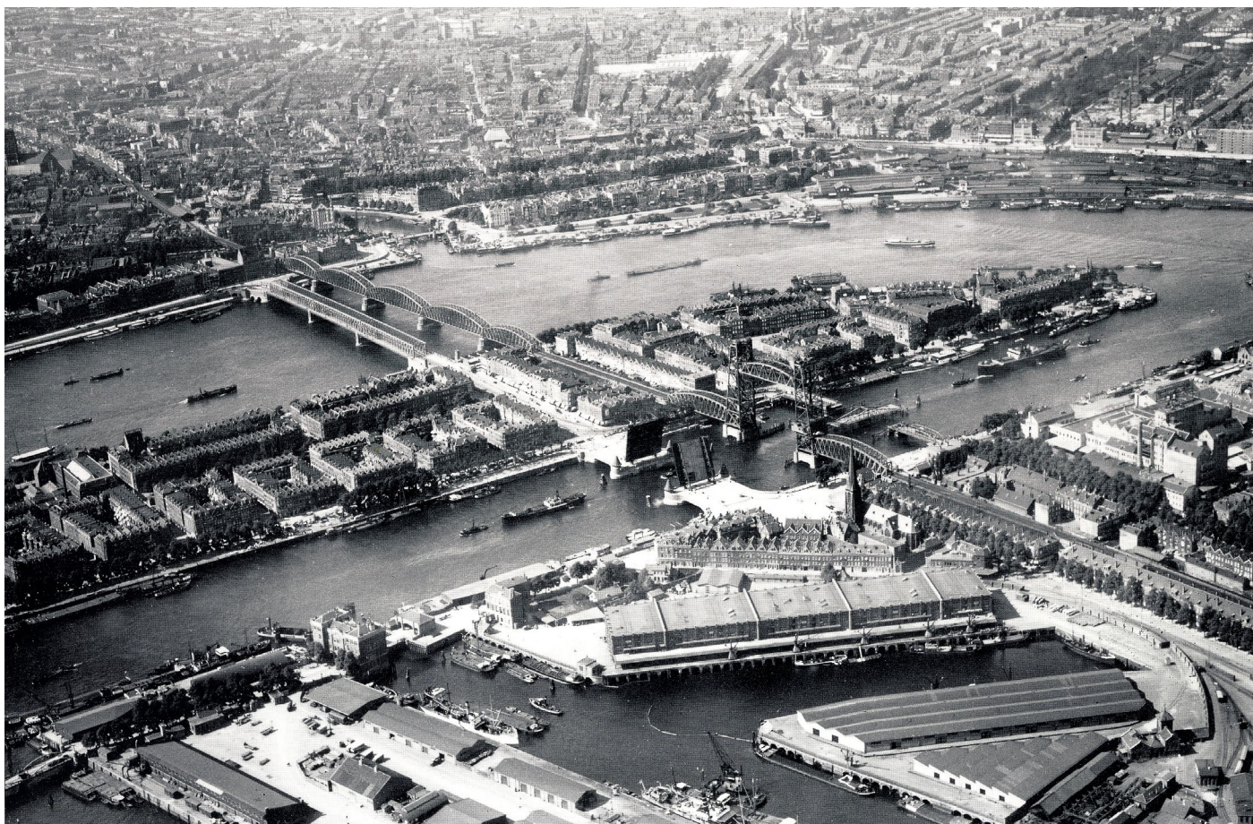
Afb. 3.2 Spoorbrug richting Noord gezien vanuit Entrepot
