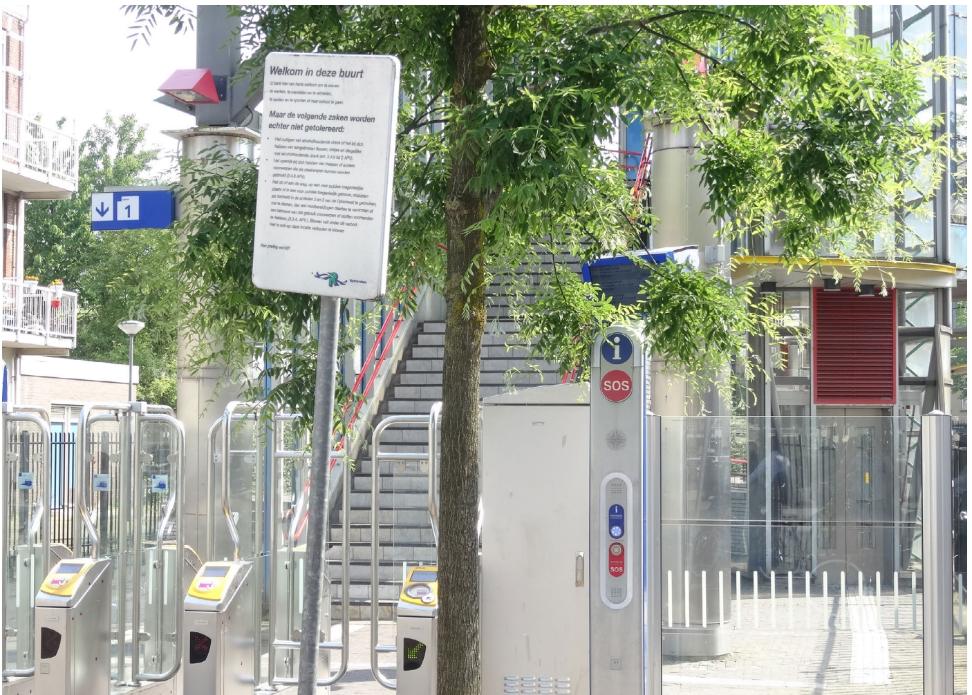
Afb. 4.13 Onaantrekkelijke entree van station Zuid
