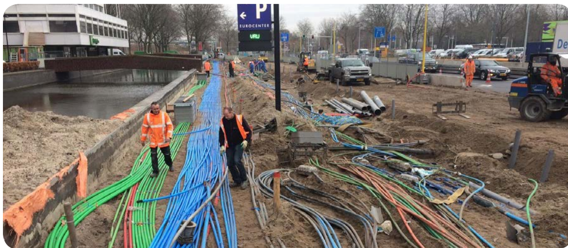
Ondergrondse infrastructuur De Boelelaan
