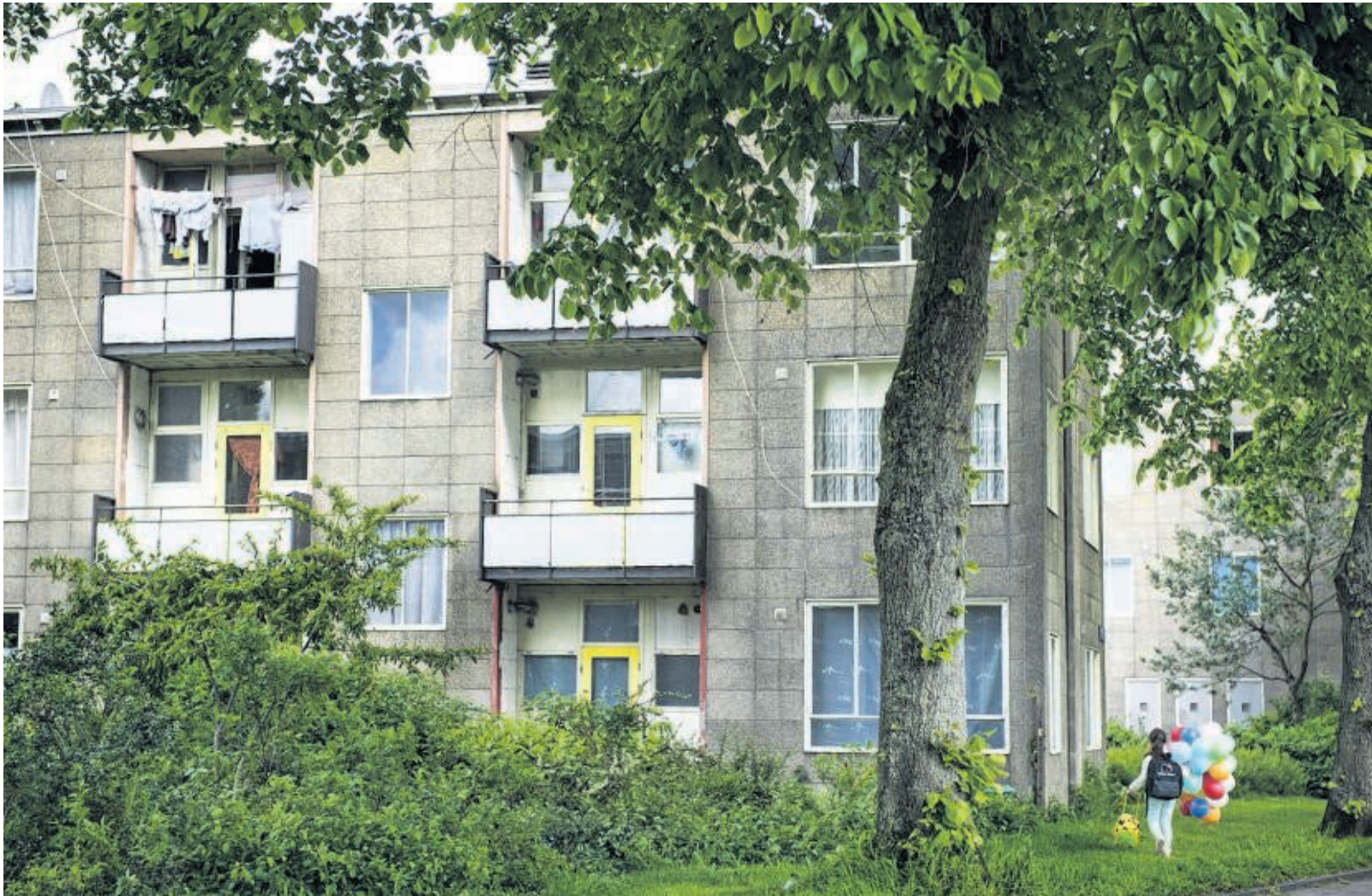
Portiekflats aan de Burgemeester de Vlugtlaan in Amsterdam Nieuw-West. In dit deel van de buurt staan nog veel jarenvijftigwoningen. FOTO PATRICK POST
